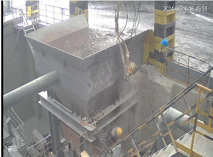
图 11 边护板（下部）吊耳掉落瞬间图片
